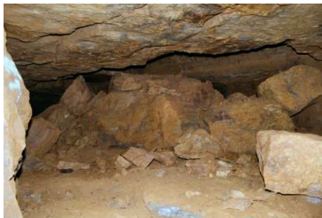
Fig. 1 : Chute de bloc dans la zone à risque d'effondrement de l'ancienne mine de fer de Moyeuvre-Grande (54).
