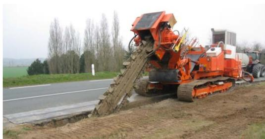
**Figure 1 :** Appareillage TrenchMix® lors de la descente de la trancheuse dans le cadre d'un chantier dit « voie sèche » au niveau de la levée de Veuves (crédit : L. Saussaye, Cerema/LRB).
